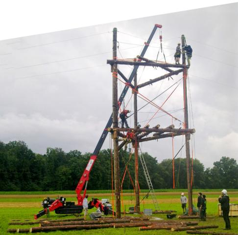
Der **UNIC 547** ist ein echtes Arbeitstier. Und der zusätzliche Hilfshaken von 80 cm ermöglicht eine weitere Traglast von 500 kg.
