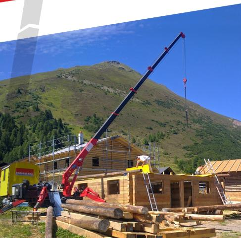
Der **UNIC 376** erreicht einen maximalen Arbeitsradius von 14,45 m. Dieser kann sowohl vom Bedienerpult am Fahrersitz bedient werden als auch aus der Entfernung mit der Standard-Funkfernsteuerung.
